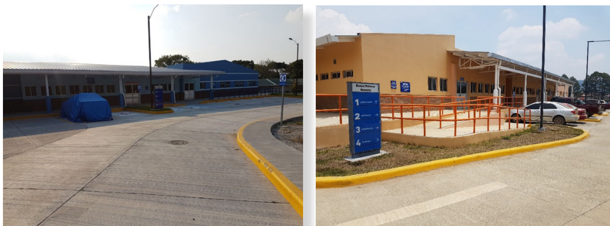
Figura n.º 2. Visita in situ a hospitales (24 y 25 de abril del 2018) para verificar la ejecución de las obras del proceso SS-PICSC-CP-168-2015. De izquierda a derecha, hospital Juan Manuel Gálvez, Gracias, Lempira, y hospital Enrique Aguilar Cerrato, La Esperanza, Intibucá)
